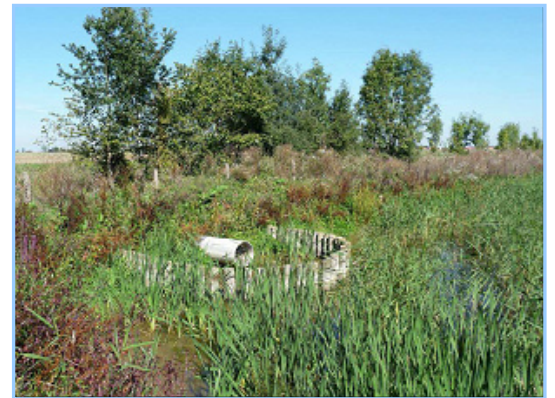
La zone tampon humide artificielle de Rampillon : un site expérimental ayant permis d'évaluer l'efficacité de ce type de dispositif en secteur drainé. Photo : Irstea
